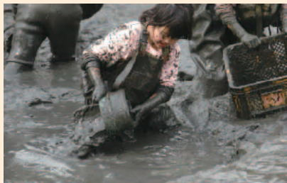
堀の底にたまった泥土を専用の桶でかき出す
